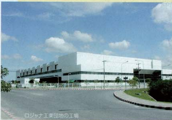
ロジアナ工業団地の工場
