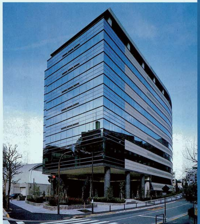
本年2月竣工した三番町東急ビル
