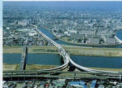
王子線(荒川アーチ橋、江北付近)
