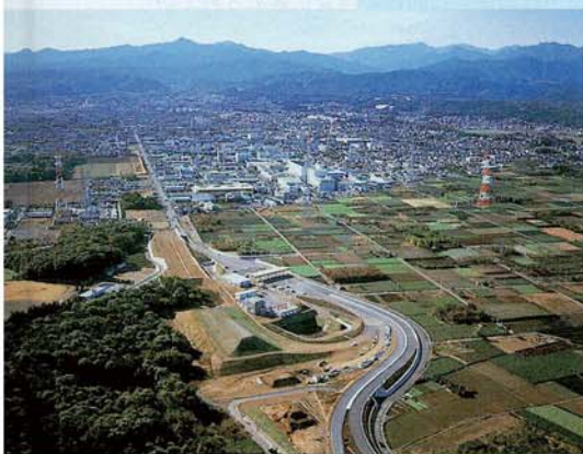
青梅IC(写真は建設中のもの)
