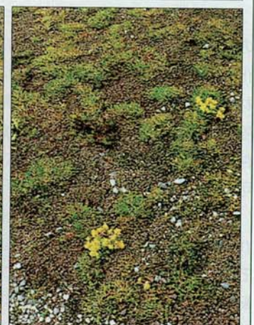
●コロニーで広がるセダム緑化。種類にもよるが、全面を覆いつくすことは難しい。
