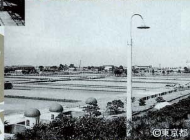
●淀橋浄水場(昭和27年)
