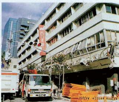
■中間層崩壊の事務所ビル
