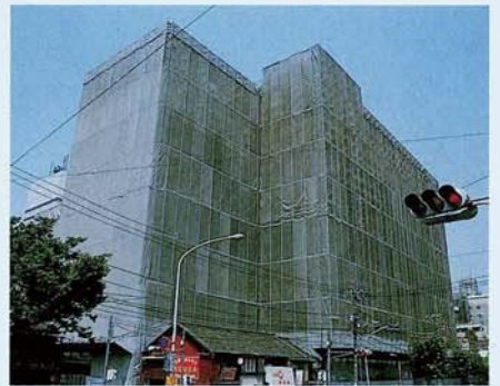
建築中の勝どきITビル（仮称）
