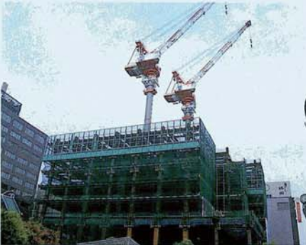
建築中の築地松竹ビル
