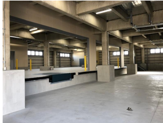
1F プラットホーム
