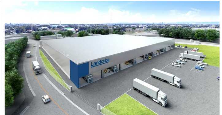
浦和（埼玉県さいたま市岩槻区） 平家建約3,223坪2023年6月竣工予定
