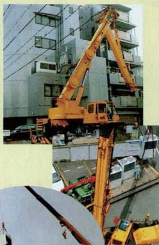
室外機の吊り上げ搬入
