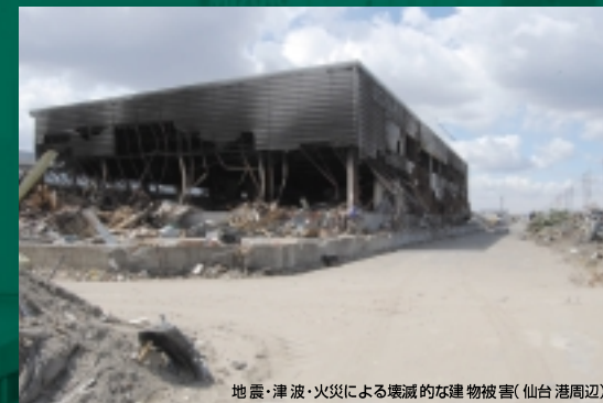
地震・津波・火災による壊滅的な建物被害(仙台港周辺)
