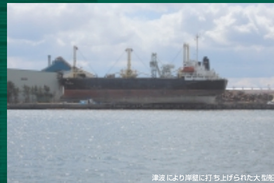
津波により岸壁に打ち上げられた大型船
