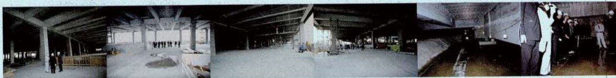
竣工を目前に控え、プリチストンスポーツの関係者を集め実施された施設内覧会の様子。
