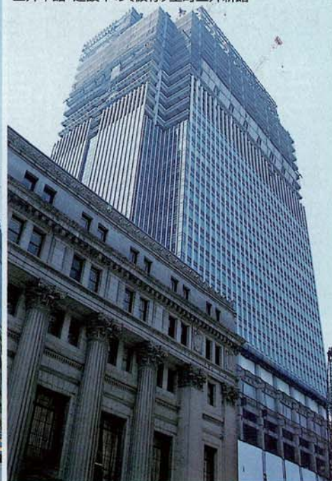
三井本館・建設中の〔仮称〕室町三井新館
