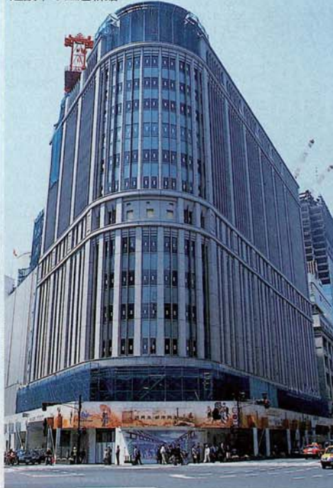
建設中の三越新館
