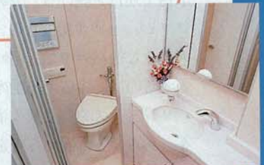
洗面台の前にいる人とブースのドアの接触を避けるために、折り戸を採用。
