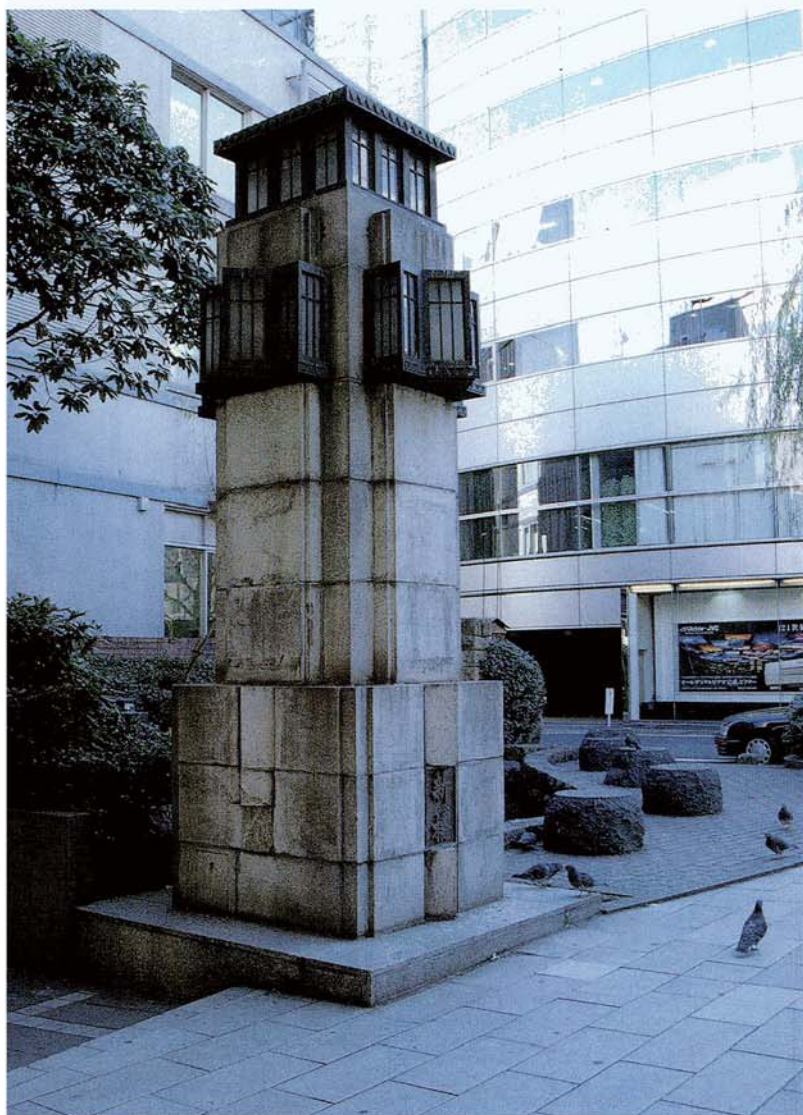
慶長6年(1601年)、新橋から銀座の入り口付近に架けられた橋が新橋だといわれています。(写真は旧新橋の橋柱)
