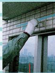
ステンレスピン挿入
