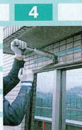
エポキシ樹脂注入
