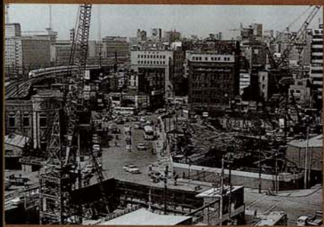
工事中の新橋駅前市街地再開発ビル
