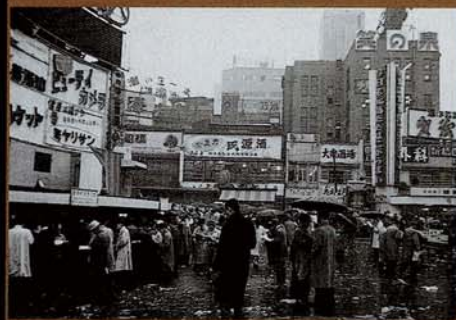
新橋駅西口広場
