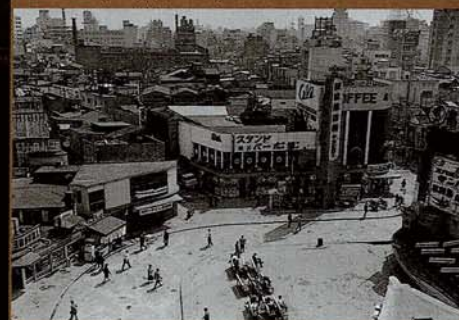
新橋駅西口広場
