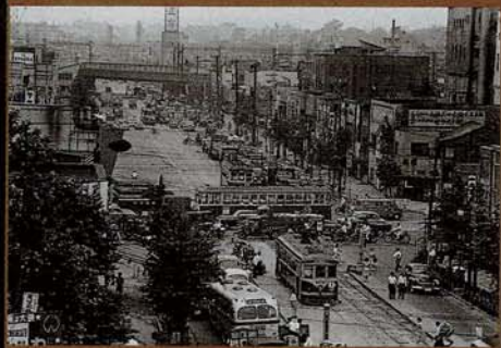
外堀通り西新橋交差点付近
