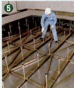
5 免震装置のレベル調整および支持脚設置
