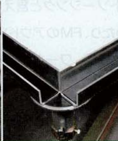
3 固定部フリーアクセスフロア施工
