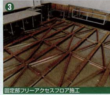
3 固定部フリーアクセスフロア施工
