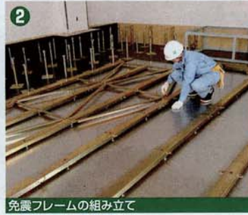
2 免震フレームの組み立て
