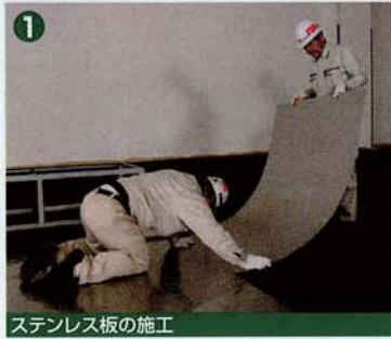
1 ステンレス板の施工
