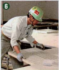
6 免震装置上にフリーアクセスフロア施工
