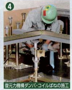
4 復元力機構ダンパ・コイルばねの施工
