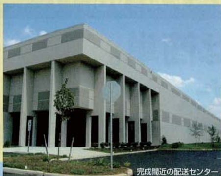
完成間近の配送センター
