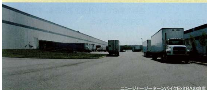
ニュージャージーターンパイクExit8Aの倉庫
