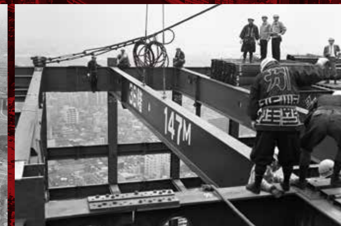
地上147m、最上階の建設現場の様子。手前の作業員の背中の「カ」は、鹿島建設の当時の商標（シンボルマーク）。（1967年3月撮影）
