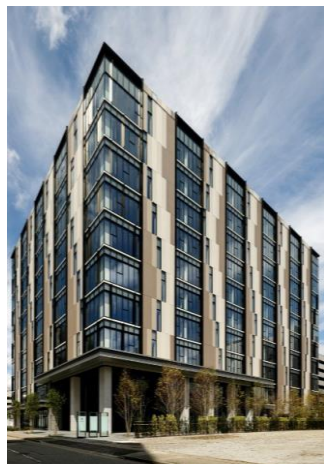
JR金沢駅西 第四NKビル
