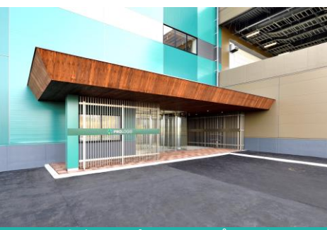
メインエントランスアプローチ
