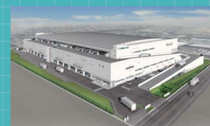
RFC川西 (着工中)
