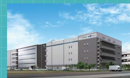
RFC市川Ⅲ (着工中)
