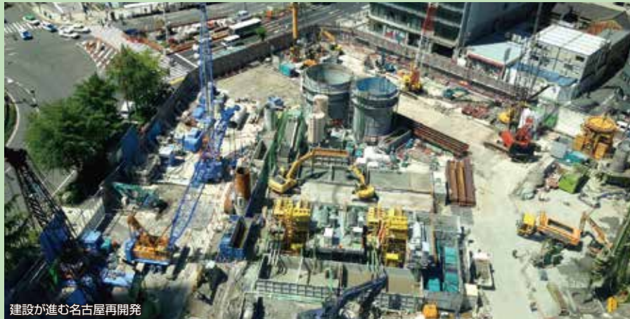
建設が進む名古屋再開発
