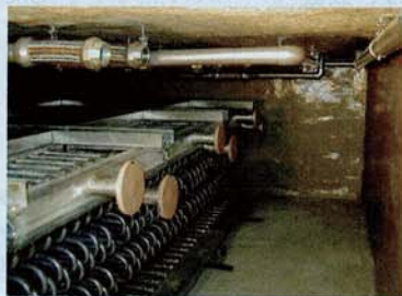
▲蓄熱槽内製氷コイル搬入据付状況
