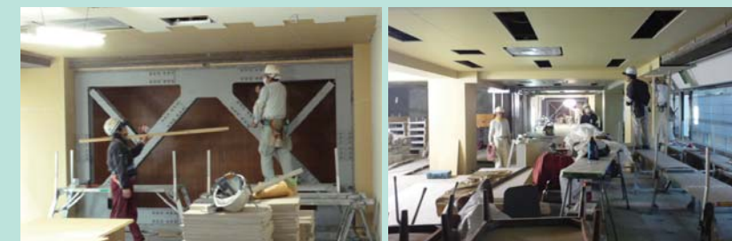
耐震補強工事の様子
