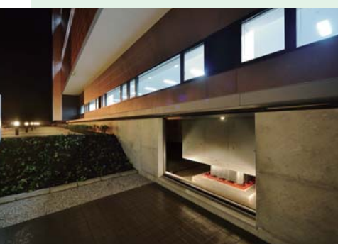
免震装置見学スペース
